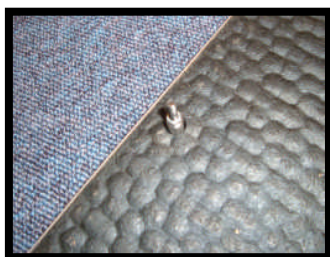
Billede 4 - Tryk Quick-Lock igennem hullerne på hhv. vinkeljern (kun forkant) og måtte. - Sæt ankeret og møtrikken på igen.
